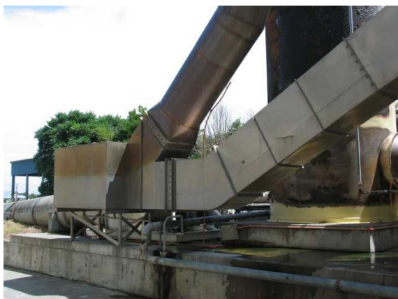
Fig 3: ID1 Fan Inlet Plenum
